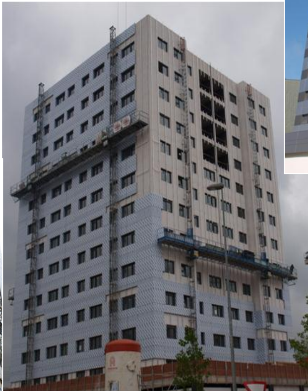
Colocación de placas sobre perfiles
