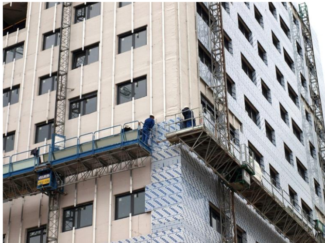
Colocación de placas sobre perfiles
