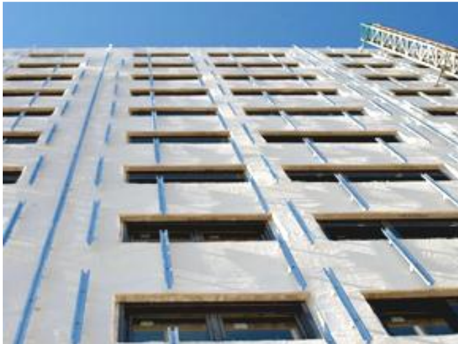
Colocación de placas sobre perfiles
