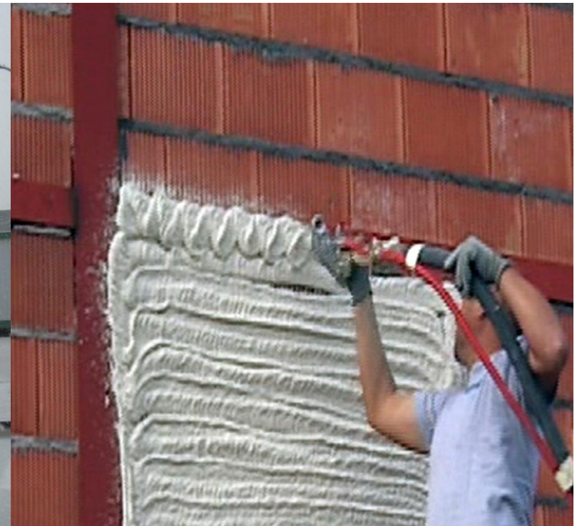
La elevada adherencia, permite aplicarlo sobre cualquier material
